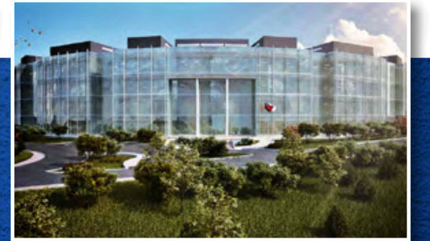
TÜBİTAK Sage Ar-Ge Hizmet Binası 2019
